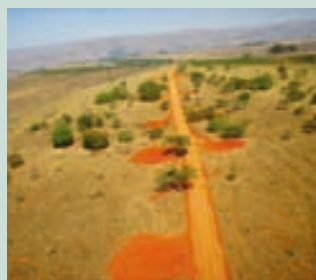
Vista aérea de estrada recuperada
