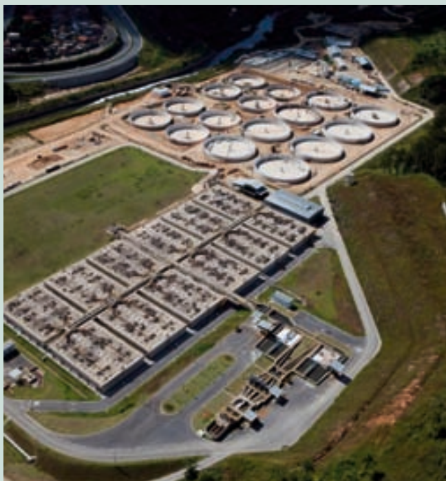
Figura 2. Vista aérea da ETE Onça. Fonte: COPASA
