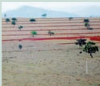
Vista da estrada recuperada
