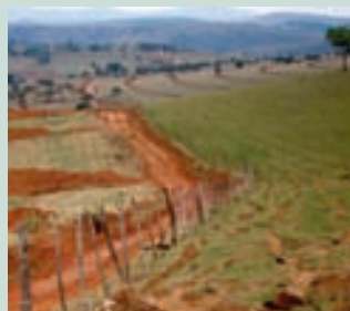
Vista parcial da estrada recuperada
